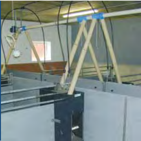
Förderspirale zur Beschickung von Futterautomaten.
